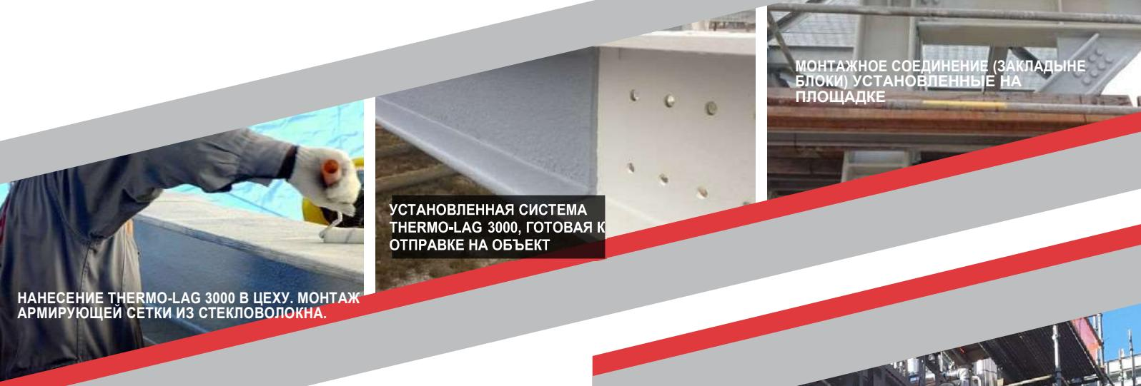
НАНЕСЕНИЕ THERMO-LAG 3000 В ЦЕХУ. МОНТАЖ АРМИРУЮЩЕЙ СЕТКИ ИЗ СТЕКЛОВОЛОКНА.
