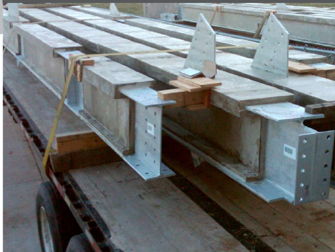
PYROCRETE®241 НАНОСИТСЯ ВНЕ ПЛОЩАДКИ И ТРАНСПОРТИРУЕТСЯ НА РАБОЧУЮ ПЛОЩАДКУ
