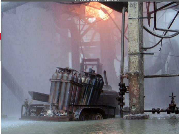
ОПОРА ТРУБНОЙ ЭСТАКАДЫ ЗАЩИЩЕНА PYROCRETE®241, ВЫДЕРЖИВАЕТ ВОЗГОРАНИЕ УГЛЕВОДОРОДОВ.
