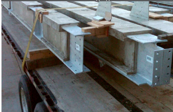
PYROCRETE ЖАБЫНЫ НЫСАННАН ТЫС ЖЕРДЕ ЖАҒЫЛЫП, КЕЙІН ҚҰРЫЛЫС АЛАҒЫНА ТАСЫМАЛДАНДЫ.
