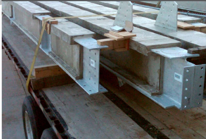
PYROCRETE®241 НАНОСИТСЯ ВНЕ ПЛОЩАДКИ И ТРАНСПОРТИРУЕТСЯ НА РАБОЧУЮ ПЛОЩАДКУ
