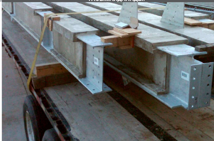
PYROCRETE ЖАБЫНЫ НЫСАННАН ТЫС ЖЕРДЕ ЖАҒЫЛЫП, КЕЙІН ҚҰРЫЛЫС АЛАҒЫНА ТАСЫМАЛДАНАДЫ.
