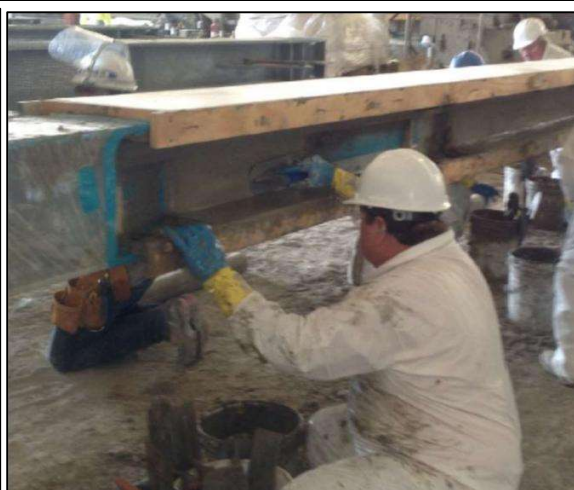
Pyrocrete-ті формалық бағыттағыштар арқылы аяқтау
