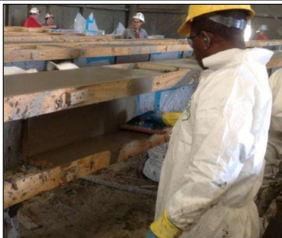
Қолданылған Pyrocrete шпательмен тегістелген
