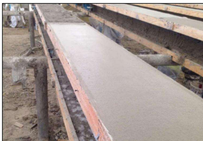
Pyrocrete қажетті қалыңдыққа жағылып, шпательмен аяқталған
