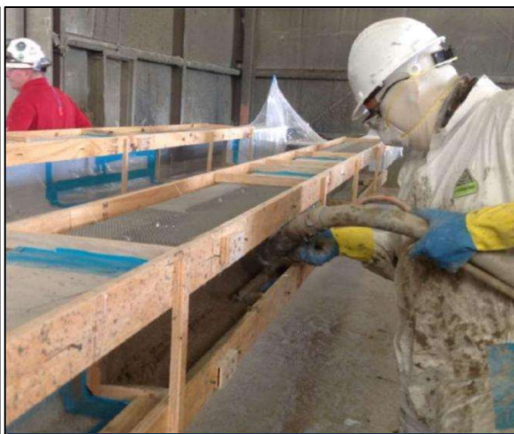
Pyrocrete талап етілген қалыңдыққа шашыранды тәсілмен қолданылған
